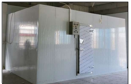
Cung cấp lắp đặt Panel kho lạnh
